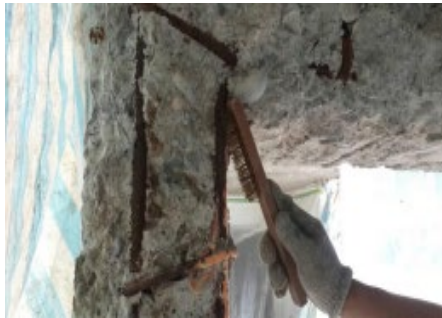
刷除外露鋼筋上的鏽層
