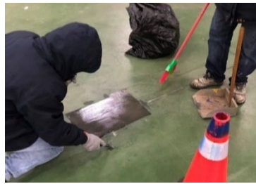
局部破損地坪修補
