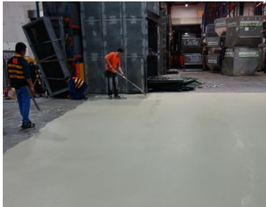
舊地坪重新鋪設翻修工程
