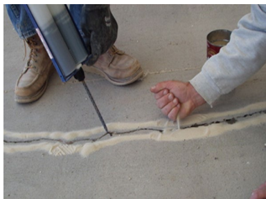
小裂縫直接灌注修補
