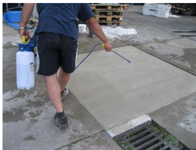
地坪局部修補工程
