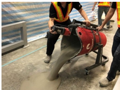
將「即固E-130自平泥」均勻鋪於地坪
