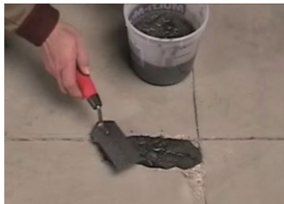
地坪崩角修補
