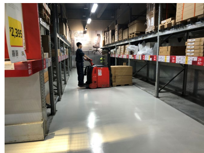
鋪設完成後24小時開放使用
