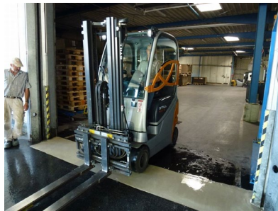
廠房入口門檻的修補工程
