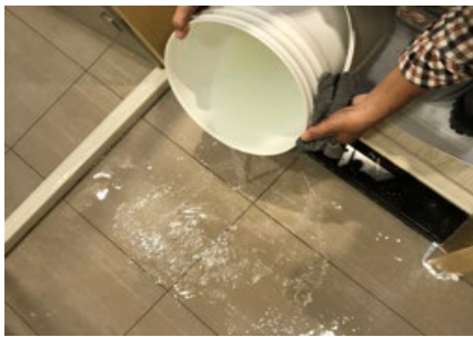
浴廁地磚以喜治漏浸淹止漏
