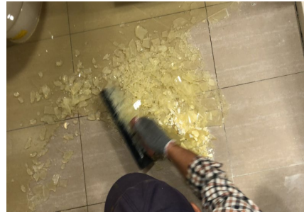
刮除已固結的矽膠體
