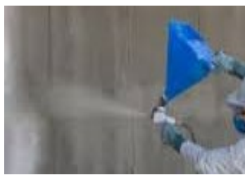
使用漏斗式噴槍噴塗施工
