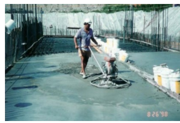
乾撒於地坪混凝土後粉光
