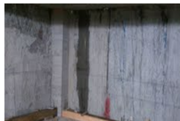
地下連續壁潮濕處以水清洗乾淨，再以硬質毛刷塗刷「克漏牆滲透結晶防水劑」。
