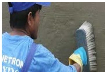
硬質毛刷塗刷牆面
