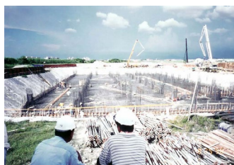
台灣奇美南科液晶廠新建工程
