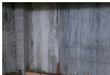
「克漏牆滲透結晶防水劑」塗刷6天後，地下連續壁牆面變乾，達到防水的功效。
