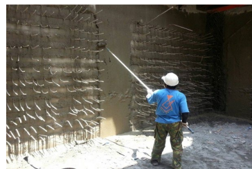
噴佈「克漏牆滲透結晶防水劑」進行筏基防水處理。
