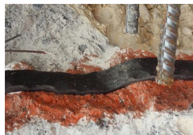
可塑型止水條與粗糙不平整 混凝土面緊密貼合
