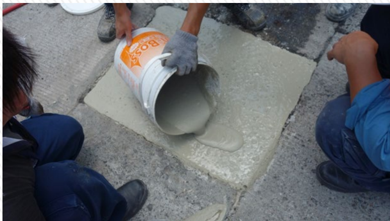
5. 路面表層以純「即固E-120」水泥砂漿補平。
