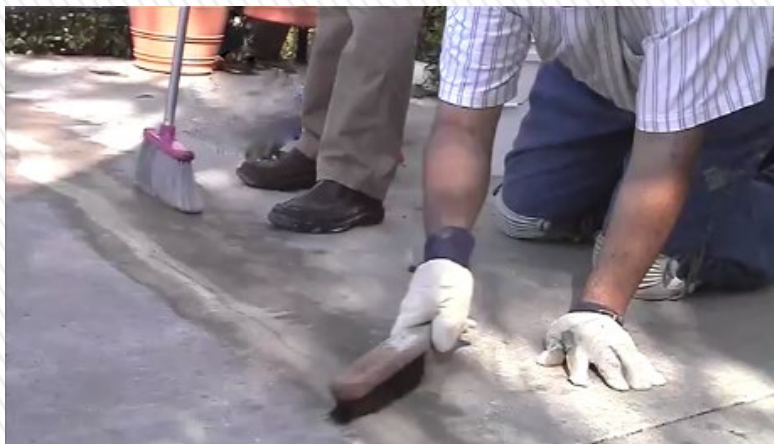
7. 將鏟平的水泥砂漿掃粗
