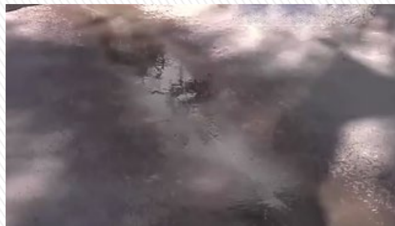
8. 立即噴水養護至表面完全硬化
