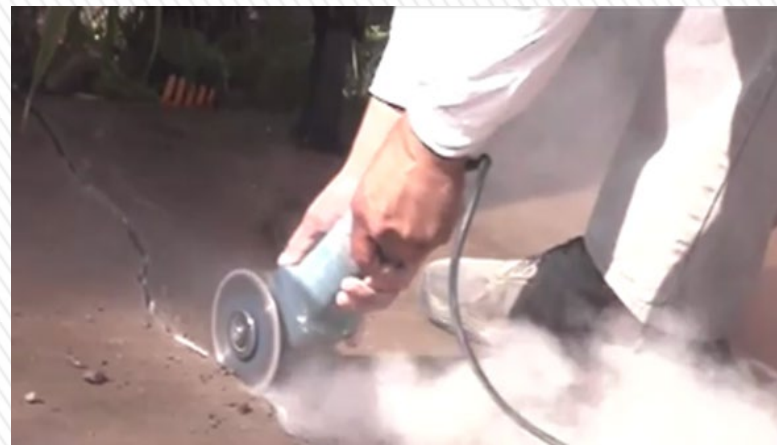
2. 使用電鋸切除鬆弛的混凝土碎塊
