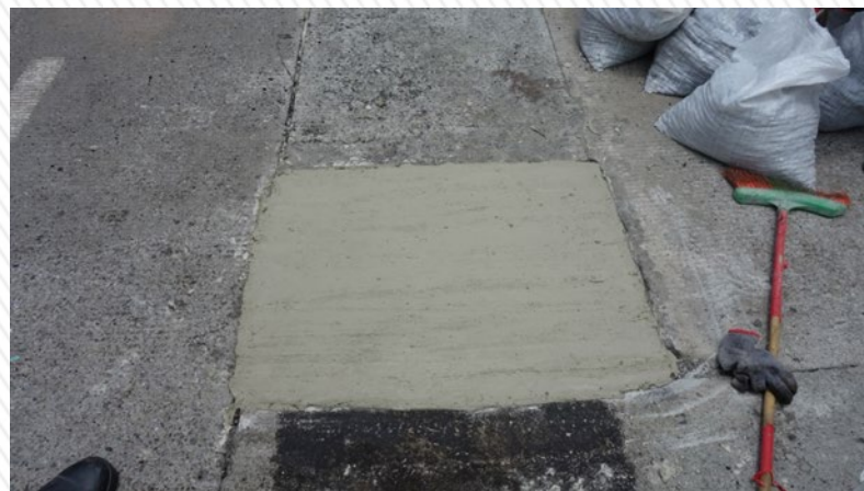
8. 路面修補完成後，立即灑水養護。
