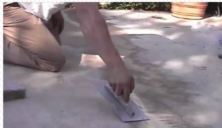
6. 將「即固E-120」水泥砂漿鏟平
