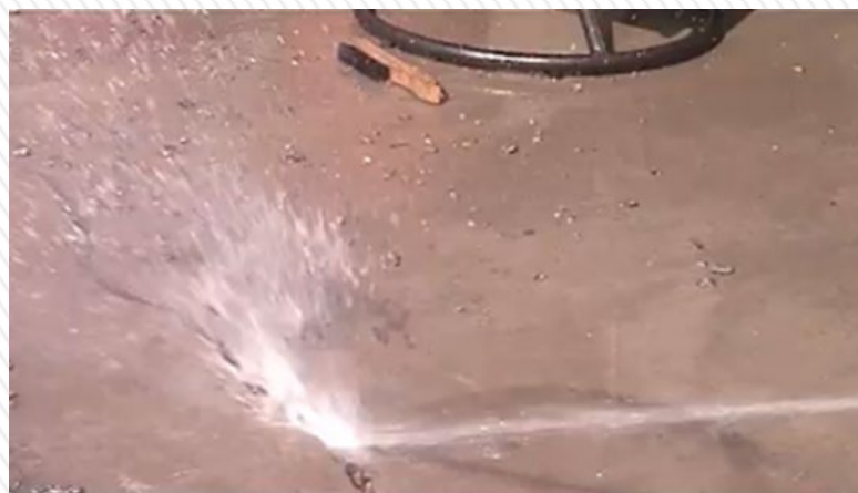
3. 用水沖洗清除裂縫中的碎塊
