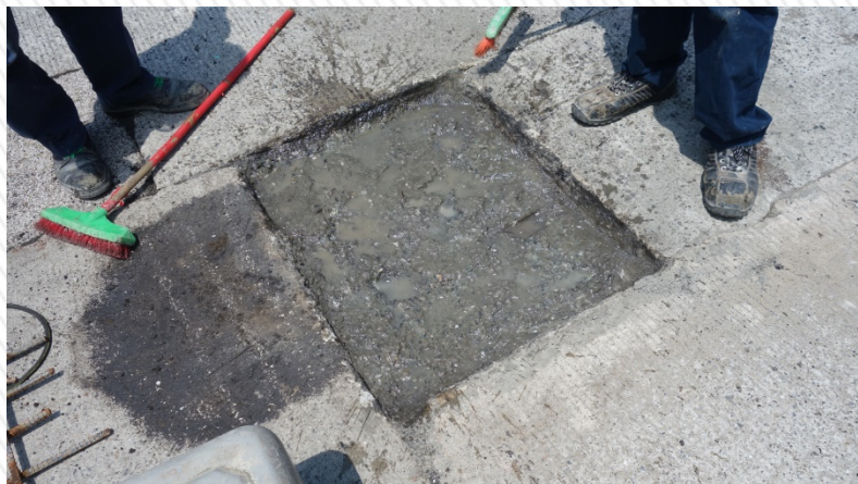
1. 路面破損處敲除，清除乾淨並濕潤處理。
