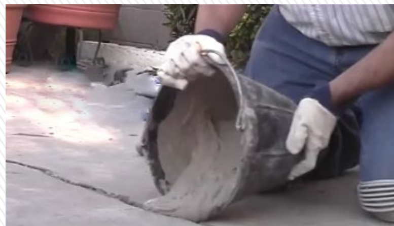
4. 沿著裂縫倒入「即固E-120」 水泥砂漿
