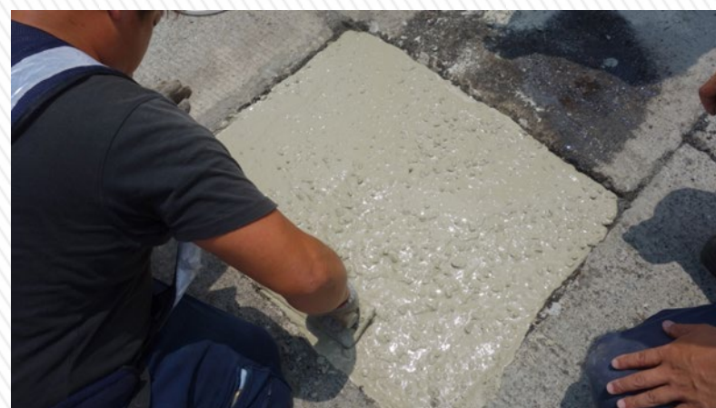
4. 鋪設其餘1/2厚度含粗骨料的「即固E-120」水泥砂漿。
