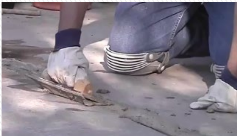
5. 將「即固E-120」水泥砂漿按壓入裂縫中
