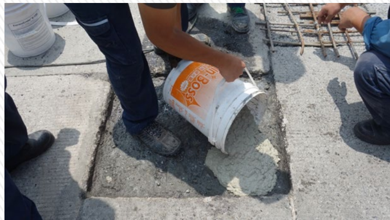
2. 鋪設1/2厚度含粗骨料的「即固E-120」水泥砂漿。
