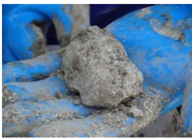
將「堵水砂漿」拌合些許水份，並捏塑固定成內乾的團塊狀。
