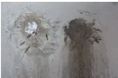
湧水孔已止水
