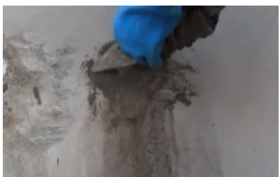
以「克漏牆防水修補砂漿」填平凹洞，並刮除多餘的砂漿。
