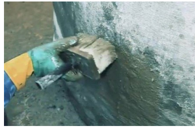
稍微潤濕表面後，最後再塗刷一層「克漏牆滲透結晶防水材」。
