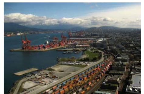
港灣耐久性混凝土結構工程
