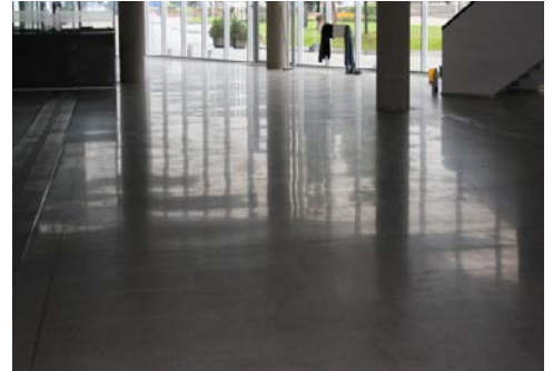
高性能混凝土地坪工程
