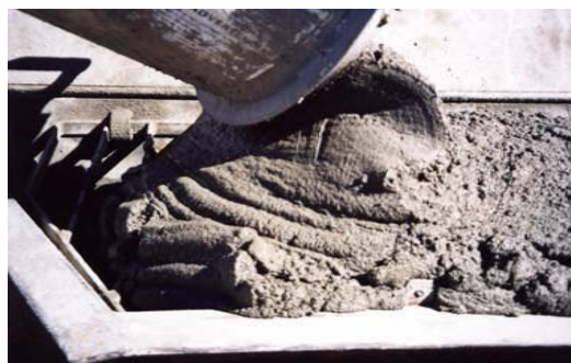
添加「即固 T-280」可增加水泥淨漿量，提高工作度。
