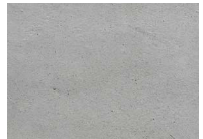
添加「即固T-280」的混凝土面 未呈現乾縮龜裂
