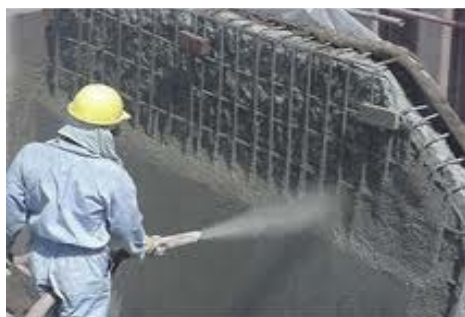
「即固 T-280」噴漿工法，附著力佳，每層噴漿厚度可堆疊至10cm以上，工作效率高。
