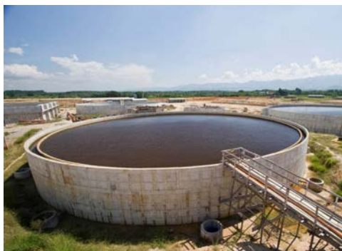
污水槽防水工程
