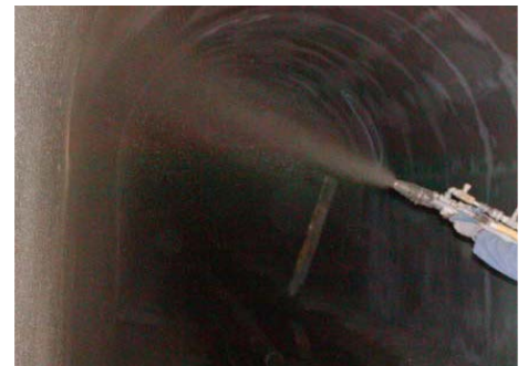
隧道內防水修復工程
