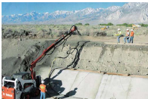
灌溉管道系統防水工程
