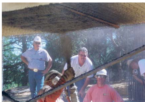
「即固 T-280」3D 板頂拱噴漿，反彈量少。
