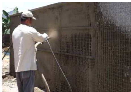
「即固 T-280」3D 板牆面噴漿打底粉刷
