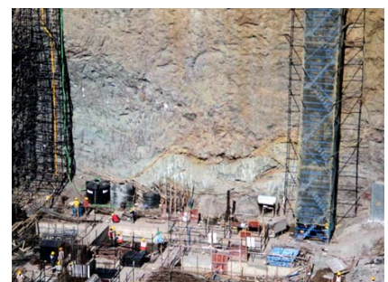
地下連續壁防水工程
