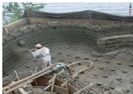
以「即固 T-280」噴漿工法建構新建游泳池的結構體，不需組模，一體成型。
