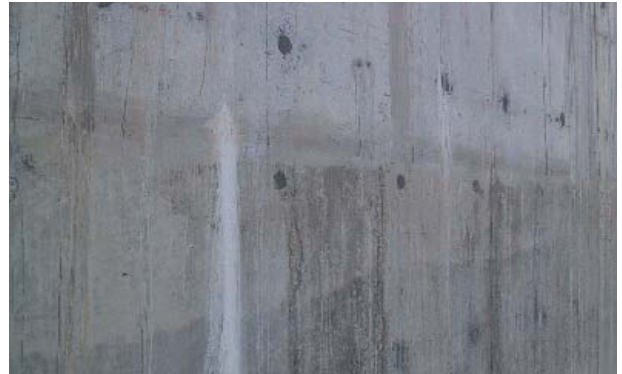
新加坡樟宜機場 T3 航站大樓的牆壁模板孔自動修復
