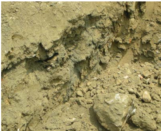
開挖並檢視水泥漿擴散的範圍
