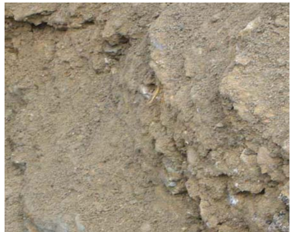
開挖並檢視水泥漿擴散的範圍
