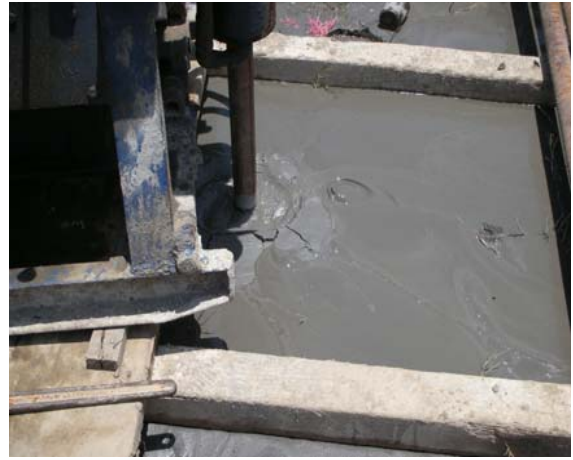
地盤改良的「滲寶」水泥漿呈淺灰色
