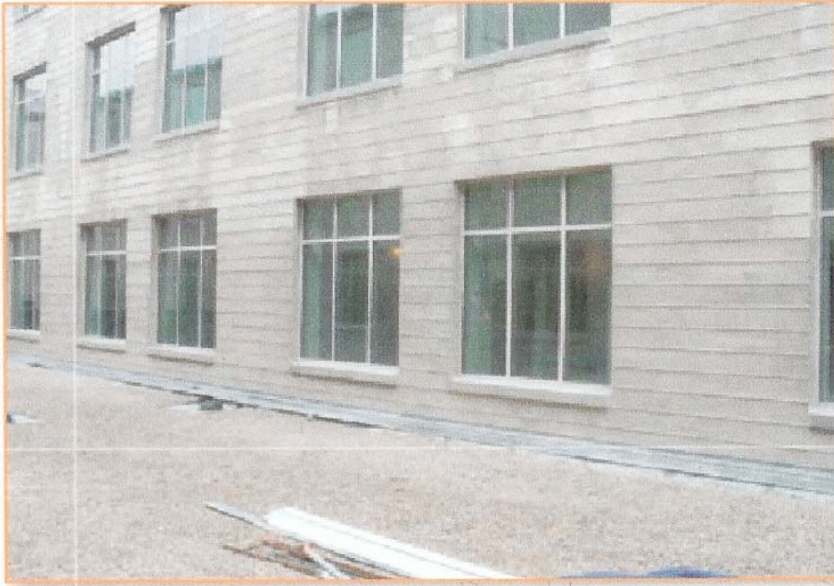
圖 6：完成防蝕的牆面，但未完成矽烷與矽酸鉀塗料的塗佈。
