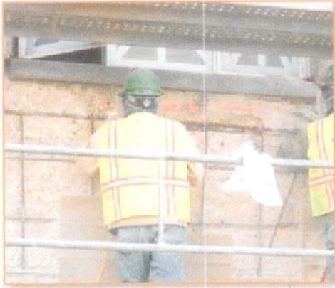
圖 3：以千斤鎚敲除腐蝕的強化鋼筋
