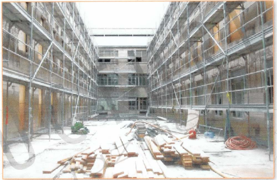
圖 1：搭鷹架以利直接在牆面上施工
