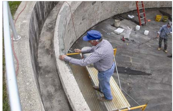
廢水處理槽的修復
