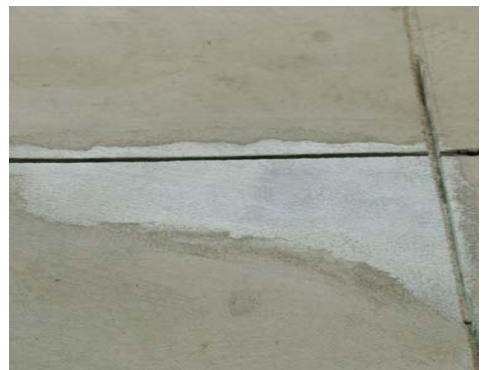
只需經10分鐘後，修補處即可立即恢復車輛通行或進行拋磨、塗裝等作業。
