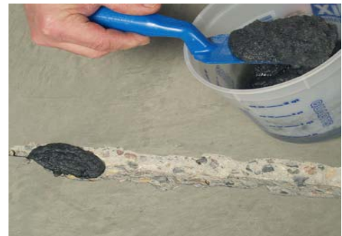
將「縫寶」硬質裂縫修補劑與石英砂、矽砂在桶中拌合後，用於修補較大的剝落處。
