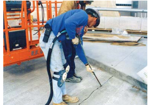
「縫寶」軟質裂縫修補劑經雙劑灌注設備拌合後直接灌注入裂縫中。
