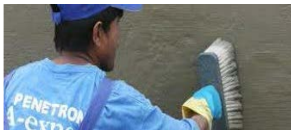
硬柄刷塗刷牆面
