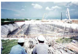
台灣奇美南科液晶廠新建工程
